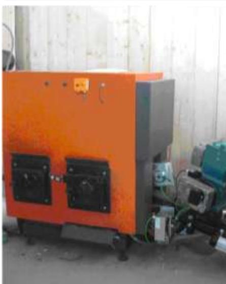
Nas Ilhas Cies, a caldeira instalada na casa dos cuidadores do Museu fornece água quente e aquecimento para uma superfície de 700 m<sup>2</sup>. A caldeira de biomassa tem uma potência de 50 kW e o silo de armazenamento possui capacidade para 27m<sup>3</sup>. A matéria-prima é proveniente de resíduos de tratamentos silvícolas das florestas existentes no Parque Natural das Ilhas Cies.
